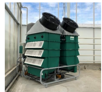
写真 2 新規導入の除湿機
